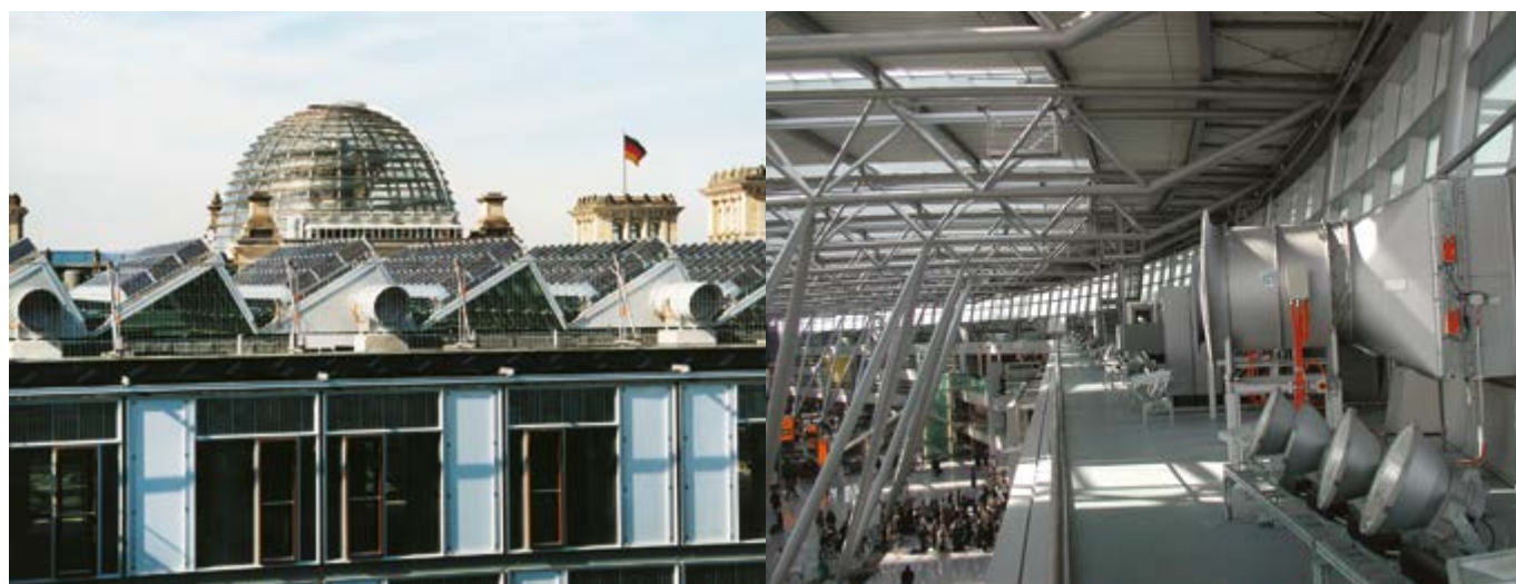
Ventiladores de cubierta para extracción de humo, serie BVD 710
